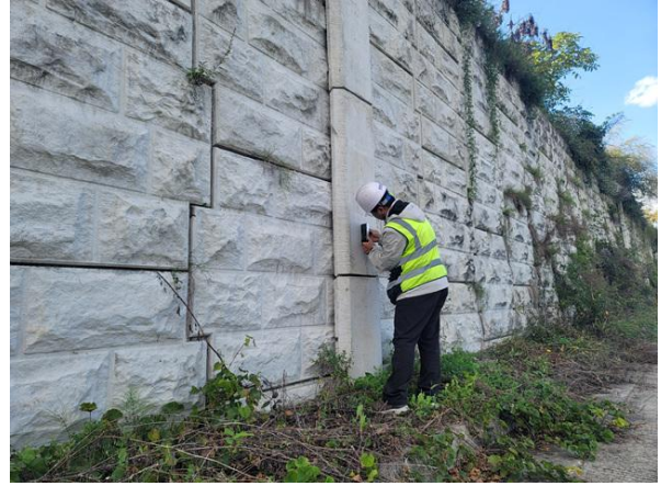
경사계를 이용한 경사도 측정사진
